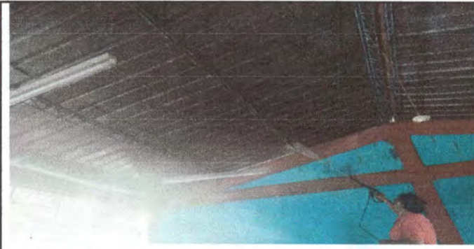
Foto 6: Mantenimiento a estructuras de soporte
