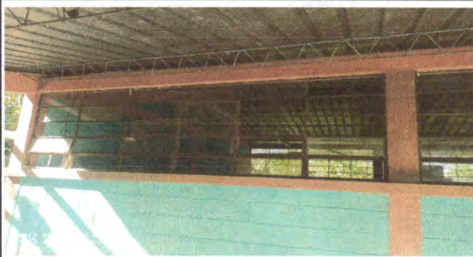
Foto 4: Colocacion de balcones
