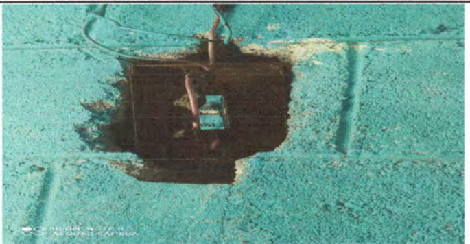
Foto 5: Cambio de cableado electrico, caja de flipones
