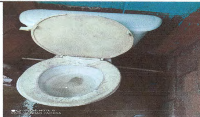
Foto 2: cambio de accesorios de sanitarios
