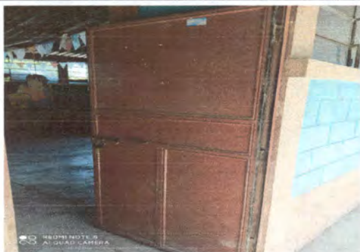
Foto 3: Sustitucion de puertas
