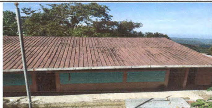
Foto1: Cambio de lamina único módulo.
